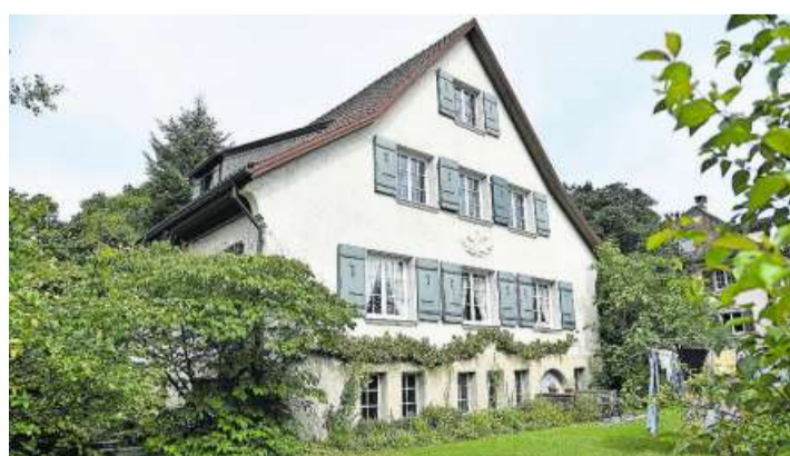
Das Organistenhaus an der Hofackerstrasse in Weinfelden muss renoviert werden. Bild: Mario Testa
